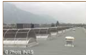
Exemple de protections solaires par l'extérieur en toiture + groupe de rafraîchissement d'air (caissons noirs)
